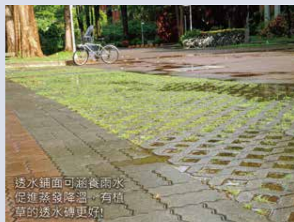
(圖7) 雲平大樓附近的透水磚可以涵養雨水，促進蒸發降溫。
