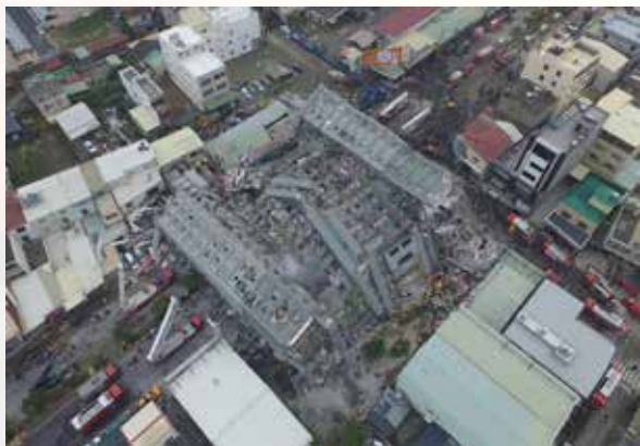
圖一、臺南市維冠大樓倒塌空拍照片。
