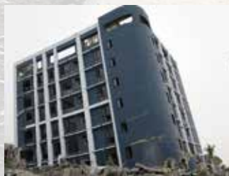
圖三、建物結構受損傾倒災情。
